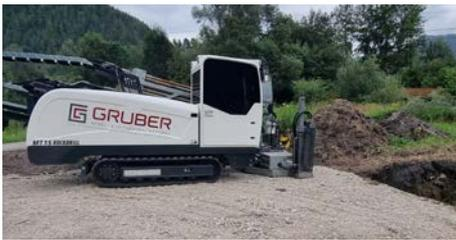
Im Zuge des Projekts kam das Spülbohrverfahren zum Einsatz: In einer Tiefe von rund vier Metern unterhalb der Flusssohle wurde ein Rohr mit einem Durchmesser von 160 Millimetern verlegt. Durch diese Bauweise konnte die Leitung geschützt und ohne größere Eingriffe in den Flusslauf installiert werden.
