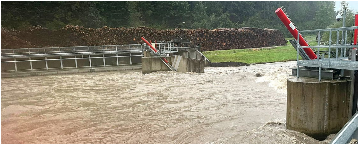
Beim Werk 1 floss die angeschwollene Mürz fast waagrecht über das komplett abgesenkte Wehr.
